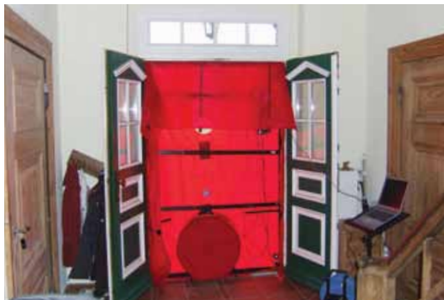
Il test Blower Door utilizza un ventilatore inserito in un ingresso che soffia l'aria verso l'esterno in modo che l'aria esterna penetri nell'edificio attraverso cricche e fessure.
