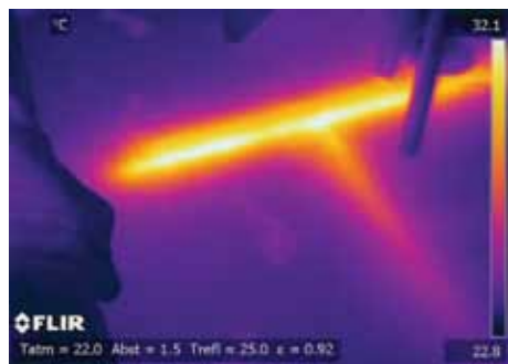
Questa immagine termica mostra dove è stato installato il tubo dell'acqua calda sotto il pavimento.
